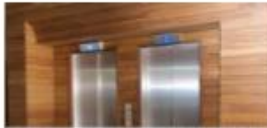
Elevatori 105 - Manutenzione impianti Elevatori
