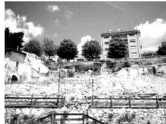
Celano - PALAZZO MARINUCCI dopo il crollo del 6 aprile
