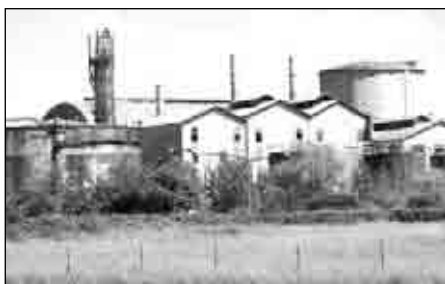
Ex zuccherificio di Avezzano. Nel 2003, per la presenza d'amianto, fu classificato come il sito più pericoloso d'Abruzzo. Tonnellate d'amianto sono ancora lì, a cielo aperto.
